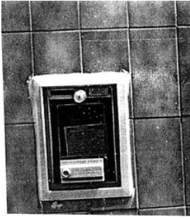
Medidor con llave térmica (tapa de policarbonato)
